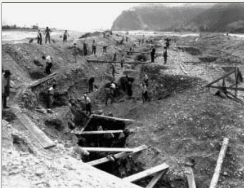
Fig. 2 – 1933 – Scavo di fondazione di un martello repellente in muratura di pietrame in località Casanova (Tolmezzo).
