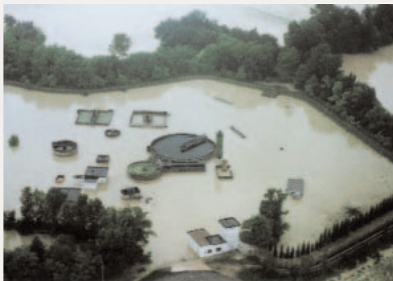
L'impianto di depurazione di Pordenone allagato dalla piena, giugno 2002
