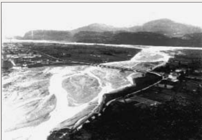
Fig. 1 – 1933 – Il torrente But alla confluenza con il Fiume Tagliamento sullo sfondo. A sx l'abitato di Tolmezzo e a dx la frazione di Caneva. Notare la direzione delle roste che devia il filone della corrente sulla sponda opposta.
