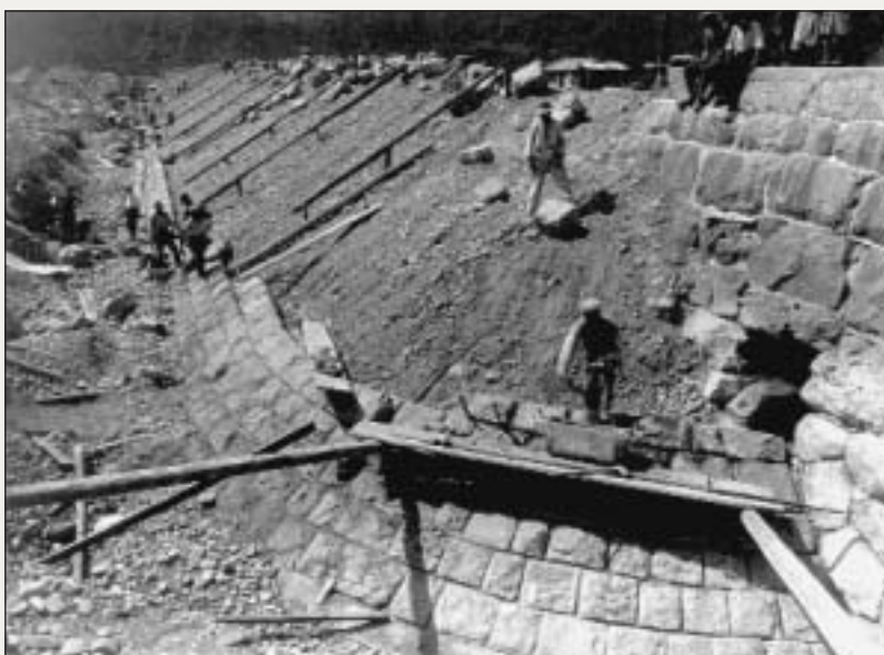
Fig. 3 – 1933 – Torrente But. Costruzione di un prolungamento della "Rosta nuova" di Caneva (Tolmezzo), in muratura di pietrame.
