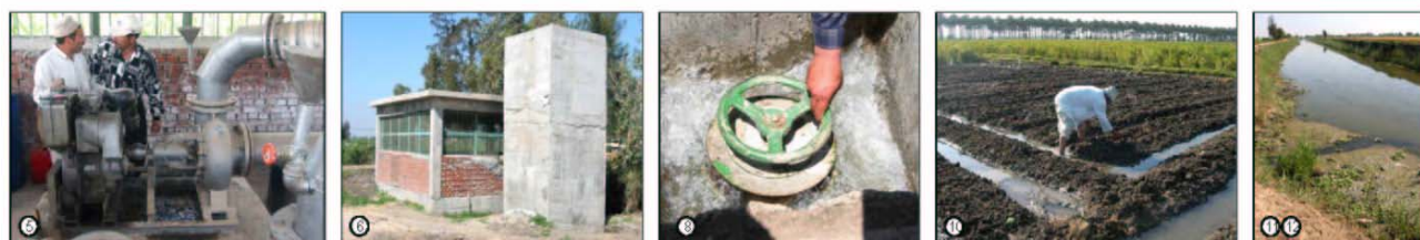
Unité de pompage collective et réseau de distribution de l'eau aux parcelles
